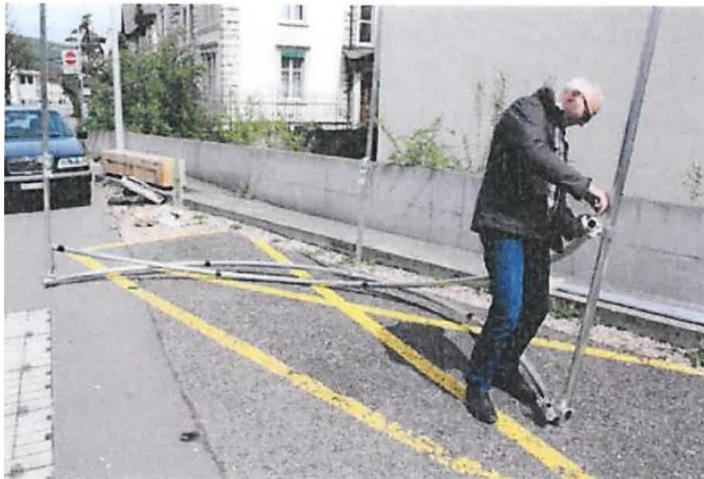
**4.** Den 2. Bogen wird an den Rohrschellen befestigt (in einem ersten Schritt an der RS 1 oder 5, dann in der Mitte an der RS 3, zuletzt an der RS1 oder 5).
