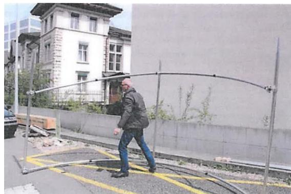
6. a) Wenn der Bogen oben ist, die zwei anderen Stangen ebenfalls an die schwarze Markierung schrauben. → **ACHTUNG! RS 2 ist BEWEGLICH! Stange gut festhalten!**
